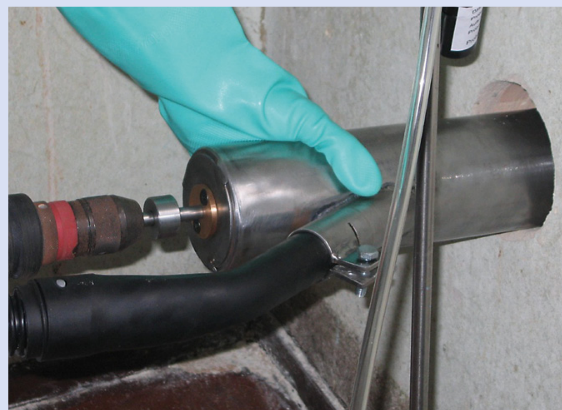
Einsatz im Gebäude: Bohrhülse, Absaugstutzen und Absaugung
