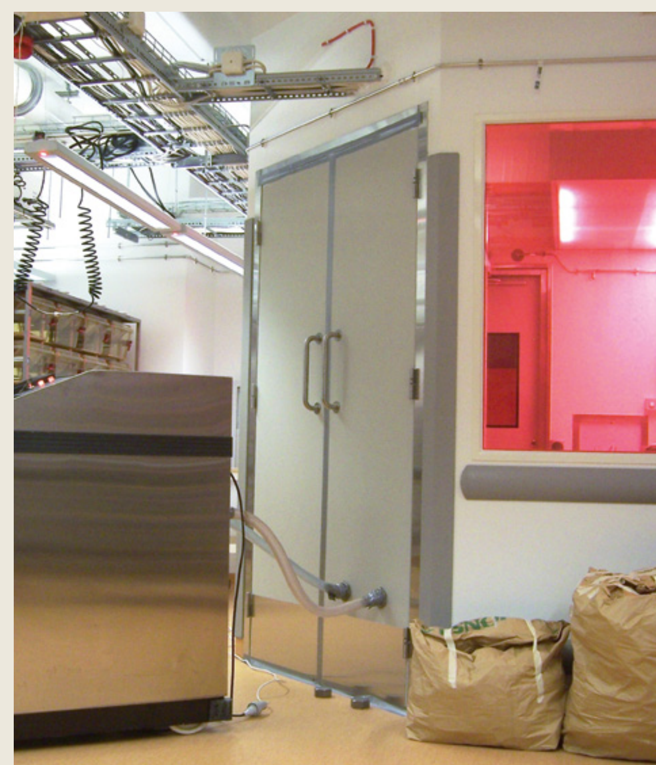
Begasung eines Tierraumes von außen
