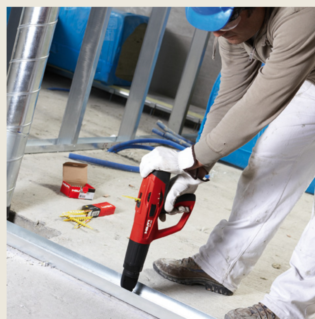
Bolzensetzen im Trockenbau
